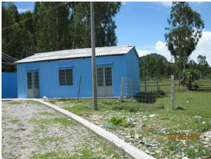
Hình 4.3: Nhà chứa mùn
