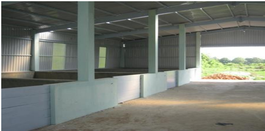
Hình 4.14: Nhà xưởng khu xử lý rác xã Hòa Bình, huyện Chợ Mới
