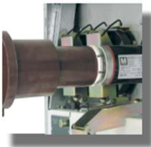
Hình 2.4 : Cầu chì Fusarc CF
