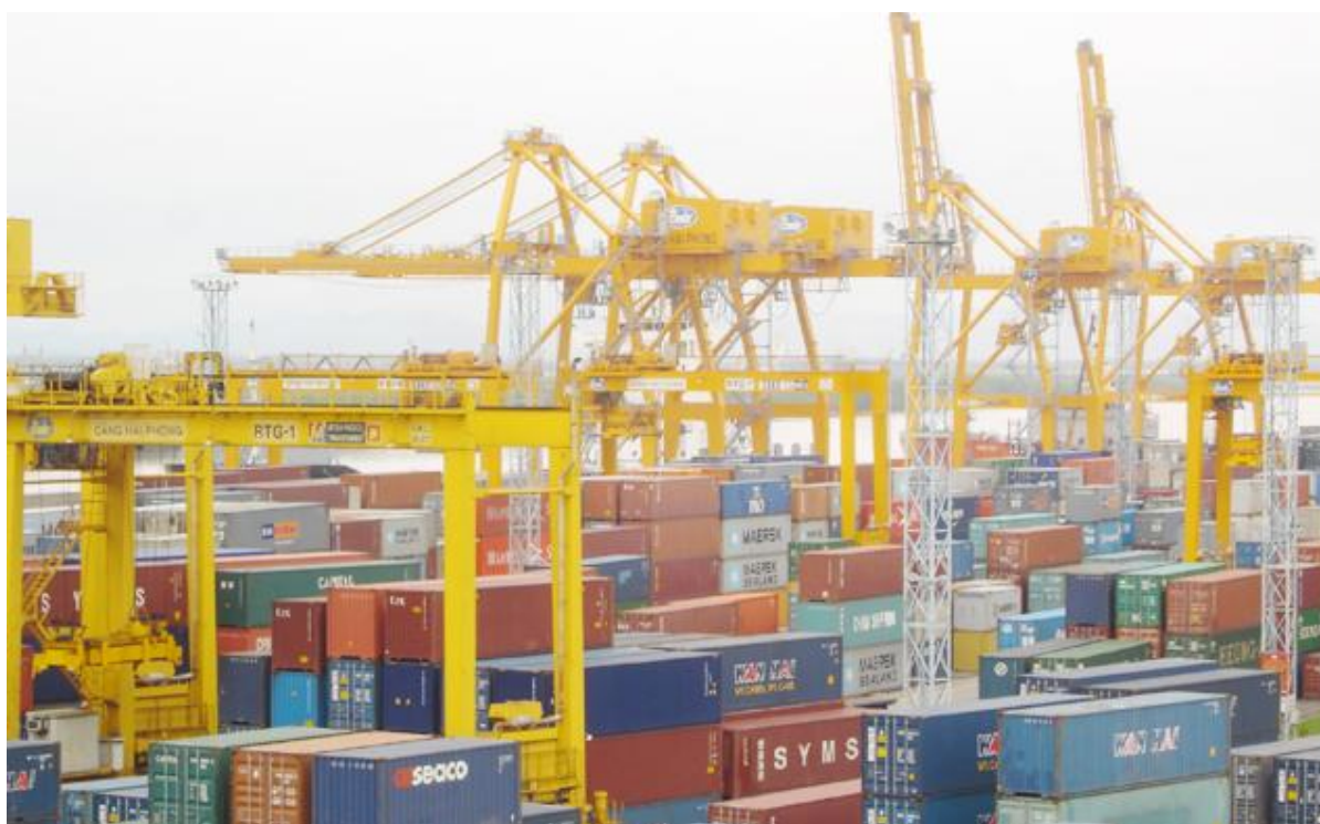
Hình 1.1. Hình ảnh về cầu trục RTG
