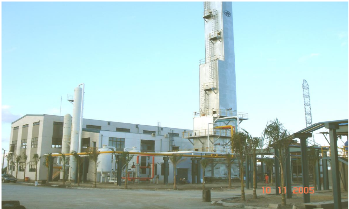
Hình 1.2. Nhà máy sản xuất khí công nghiệp.
