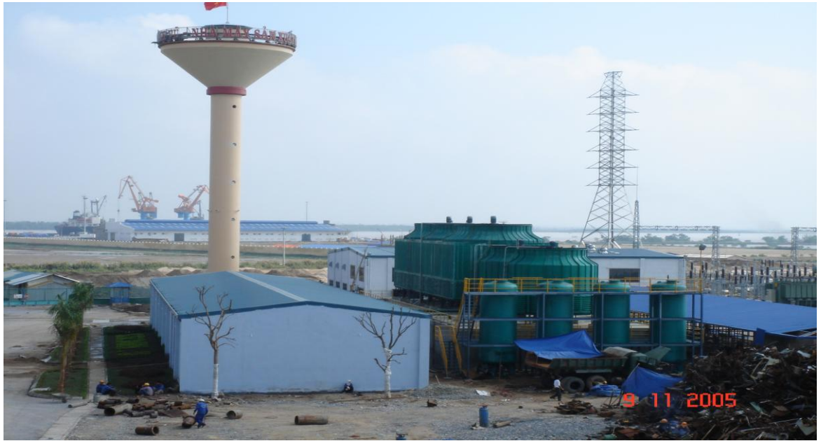
Hình 1.3. Hệ thống xử lý nước.
