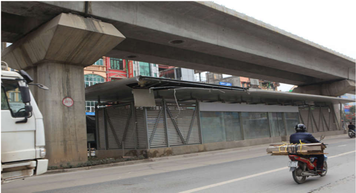
Hình 2.9 Nhà chờ BRT trên đường Quang Trung
