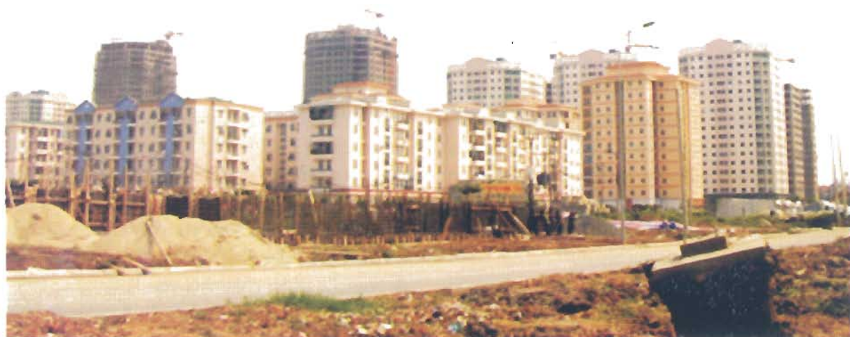
Những công trình xây dựng mới ở ngoại vi huyện Tứ Liên, Hà Nội
