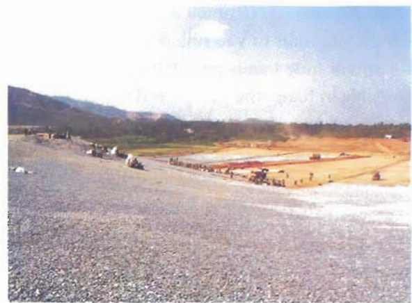
Bãi rác thải đang được xây dựng ở Đà Nẵng
