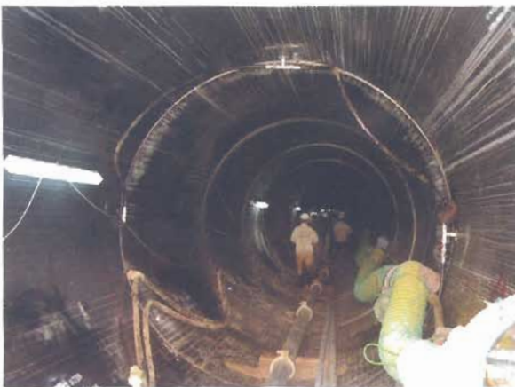
Đường công thoát nước thải dưới kênh Nhiêu Lộc - Thị Nghè - TP. Hồ Chí Minh
