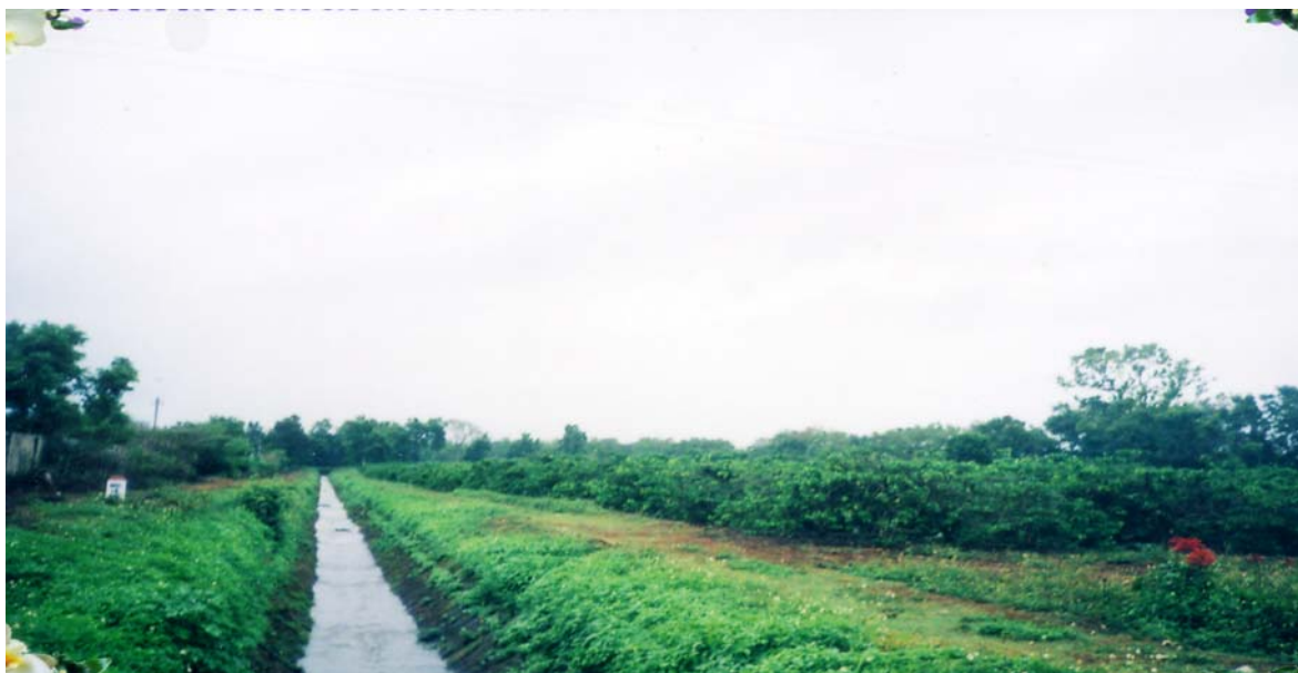
Thủy lợi được kiên cố hóa kênh mương
