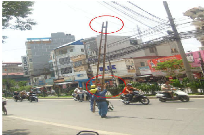
Hình 3.8 Hình ảnh dùng thang đỡ dây qua đường
