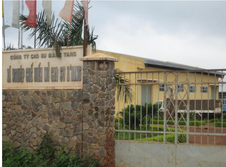
Hình 2.1: Nhà máy chế biến mủ cao su K'Đang
