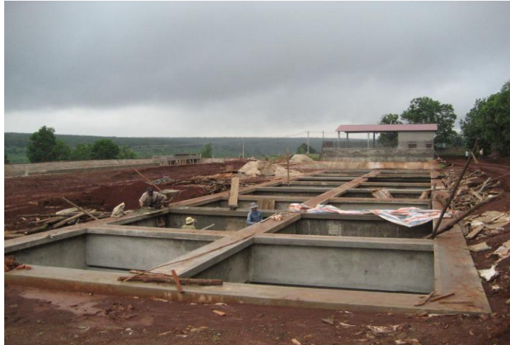
Hình 2.3: Hệ thống xử lý nước thải đang xây dựng
