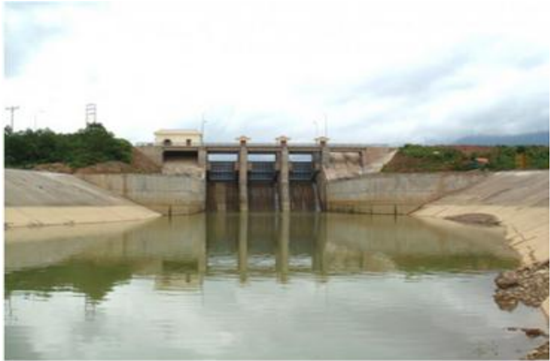
Hình1.3: nhìn từ hạ lưu tràn xả lũ
