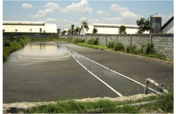
Hình 14. Bể sục khí số 2
