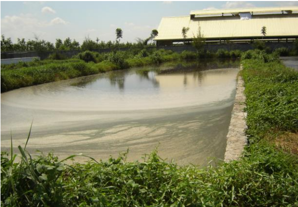
Hình 15. Bể hoàn thiện số 1
