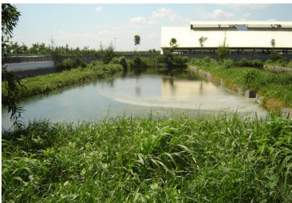
Hình 17. Bể hoàn thiện số 3
