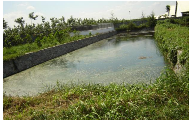
Hình 16. Bể hoàn thiện số 2
